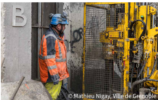
Foreuse permettant d'injecter le coulis de ciment pour réaliser la colonne
