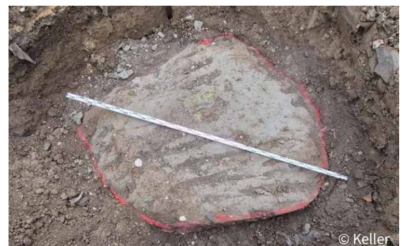
Réalisation d'une colonne de jet grouting (test)
