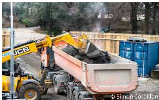
Les boues, appelées, les « spoils » remontées depuis les zones de forages, sont ensuite filtrées et évacuées, l'eau ainsi récupérée est réinjectée dans le système.
