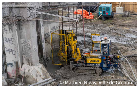
Réalisation de la colonne située entre deux piliers
