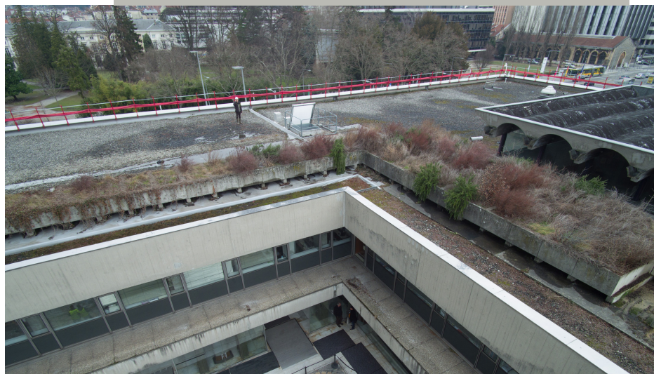
Toiture de l'Hôtel de Ville
